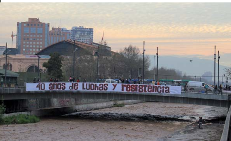
| Cara oriente del puente La Paz
