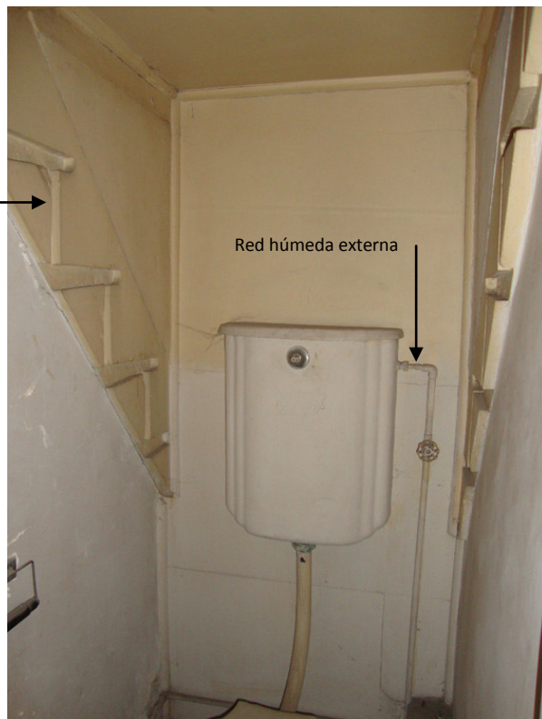
Baño 2, vista muro sur (Fuente: artOficio, 2010 mayo (MS), p. 27).
